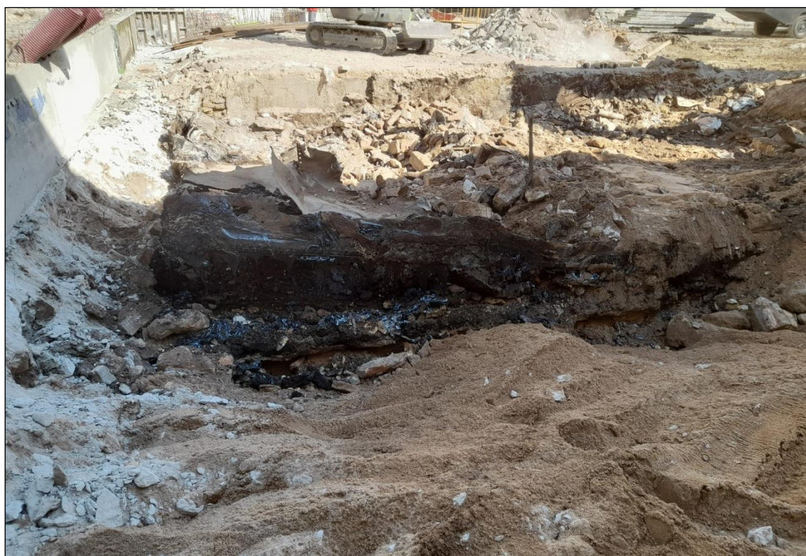
Figura 22. Base de formigó d'un dels dipòsits situats al solar.
