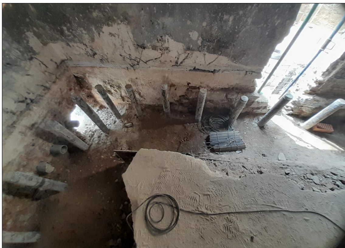
Figura 20. Estat de la sala B a l'acabar d'instal·lar els micropilots.
