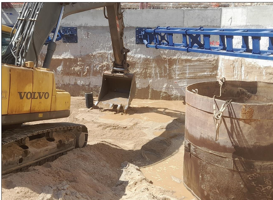
Figura 28. El nivell freàtic ja apareix al final del rebaix.
