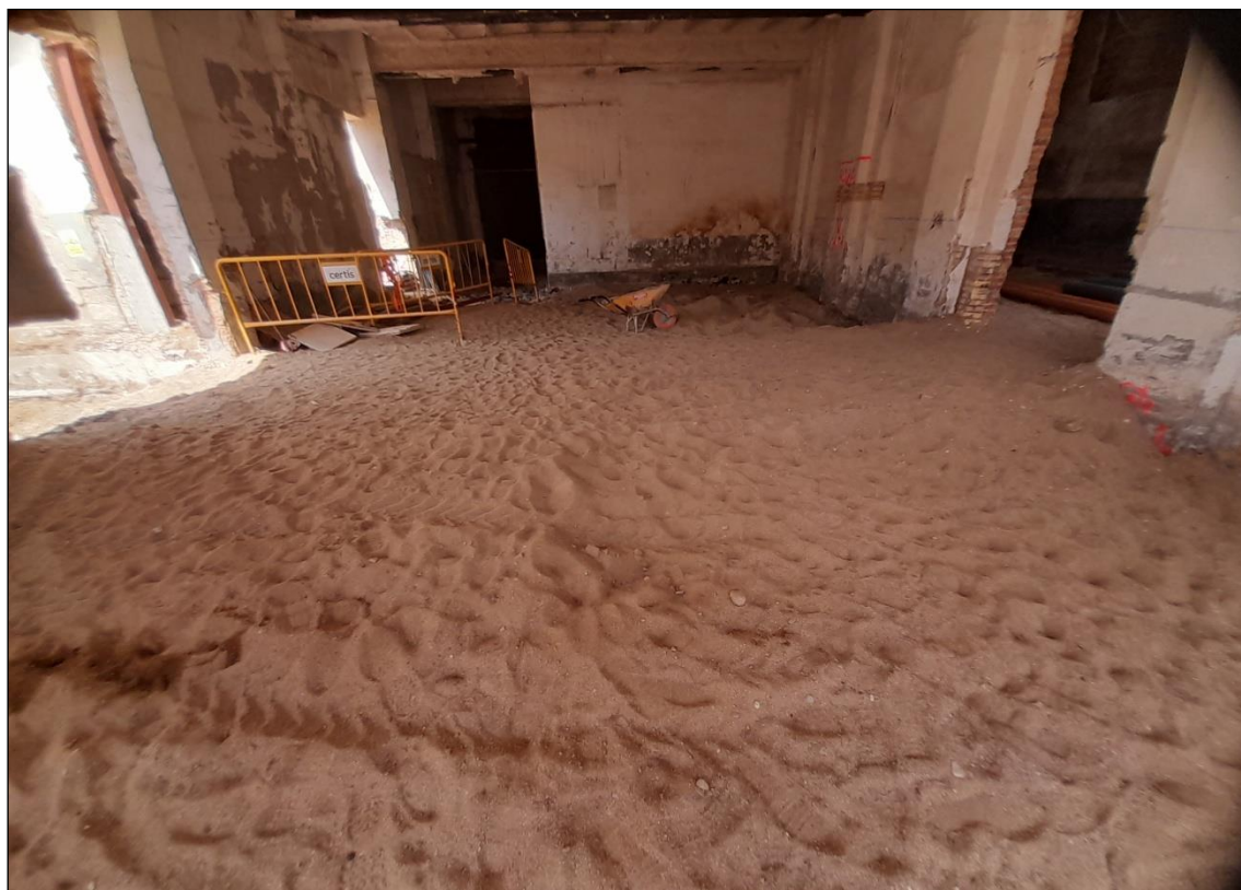
Figura 30. Final del rebaix de la sala C.
