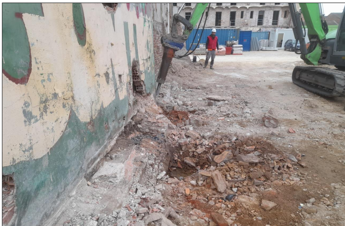
Figura 8. Segona trinxera. S'ha hagut de picar els fonaments de la fàbrica per fer-la.
