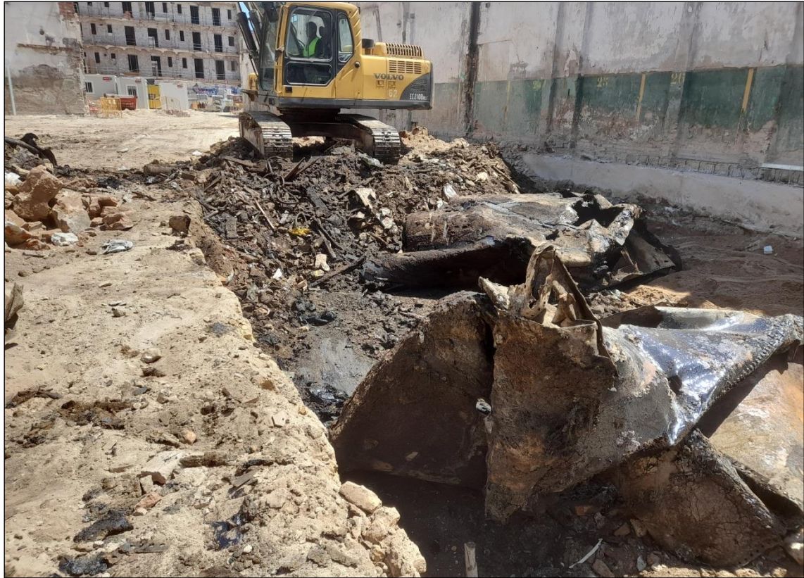
Figura 23. Desmantellament dels dipòsits, s'observa com estava omplerta de runa i la carcassa metàl·lica.
