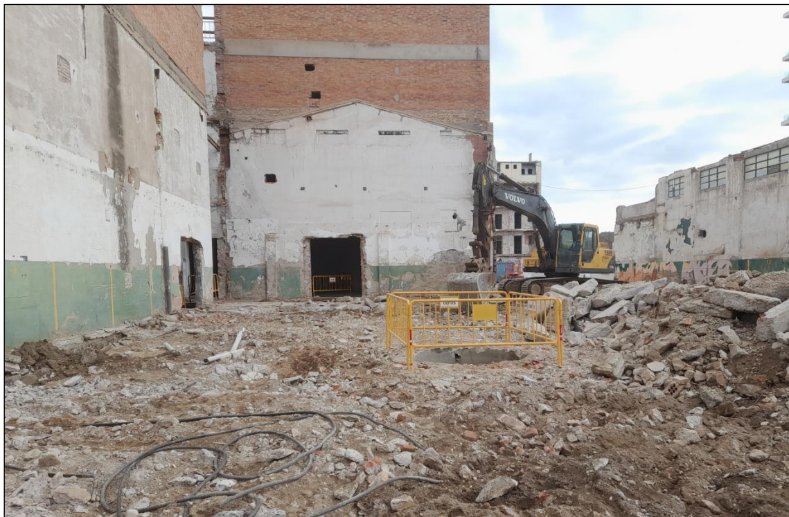
Figura 3. El solar aixecada la solera de formigó, amuntegada a la dreta.
