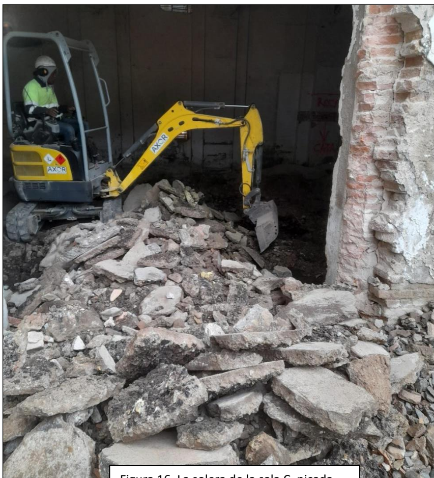
Figura 16. La solera de la sala C, picada.
