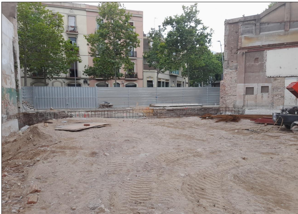
Figura 18. Estat del solar al iniciar el rebaix final.
