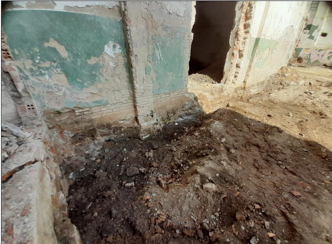
Figura 12. Cantonada entre rases 3 i 4. S'observa la runa barrejada amb el sediment argilós i sorrenc.
