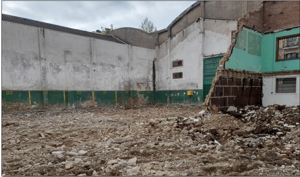
Figura 4. El pati un cop remoguda la solera. S'observa la runa i terra disgregada a sota.
