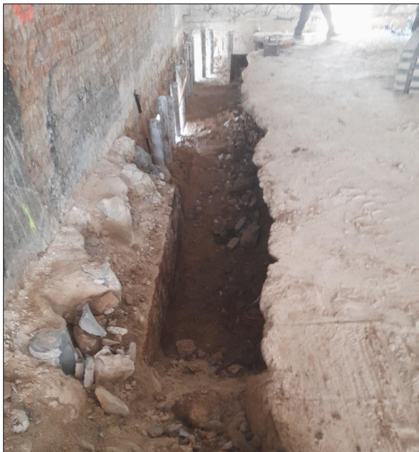
Figura 21: Els micropilots col·locats al perímetre i la runa sota la solera inicial.
